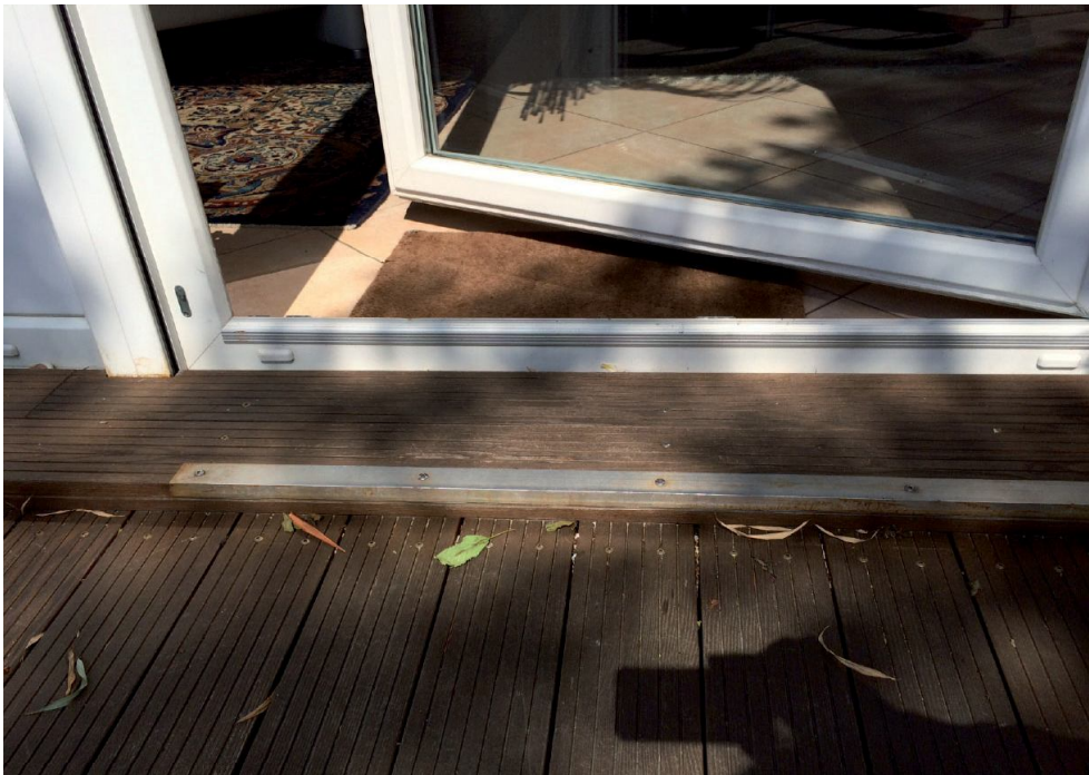
Abb. 3.3-2 Typische Schwelle an einer Terrassentür. Hier ist die Situation besonders kritisch, da von innen nach außen betrachtet eine Kante in Kombination mit einer Fußmatte vorliegt und von außen nach innen sogar zwei unterschiedlich hohe Kanten zu überwinden sind.
