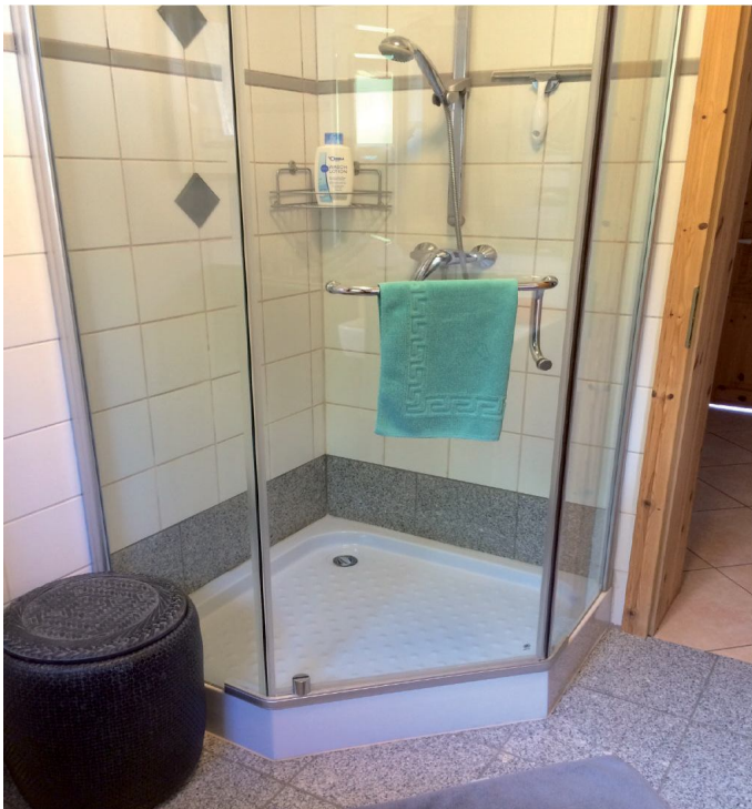
Abb. 3.3-7 Ein hoher Einstieg in die Duschwanne – die Dusche ist sehr klein und verfügt nicht über Haltegriffe oder eine Sitzgelegenheit.
