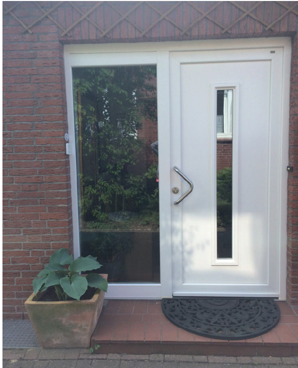
Abb. 3.3-4 Hauseingang mit Stufe und ohne Geländer
